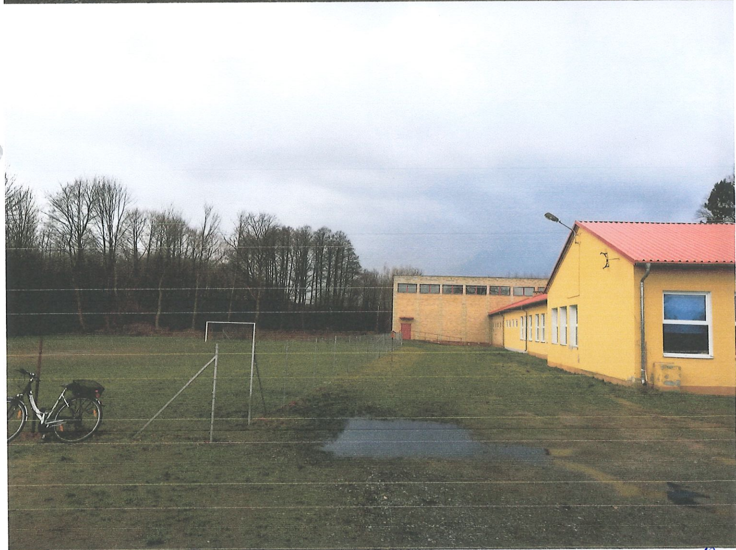
TEREN INWESTYCJI - BUDYNEK SZKOŁY
