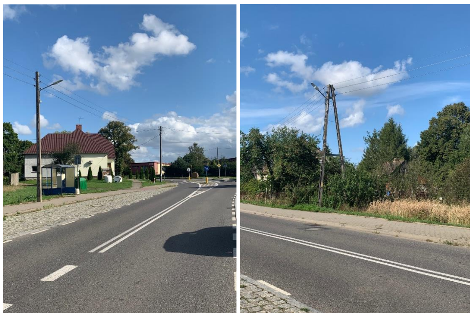
Budowa chodnika w miejscowości Mechowo
