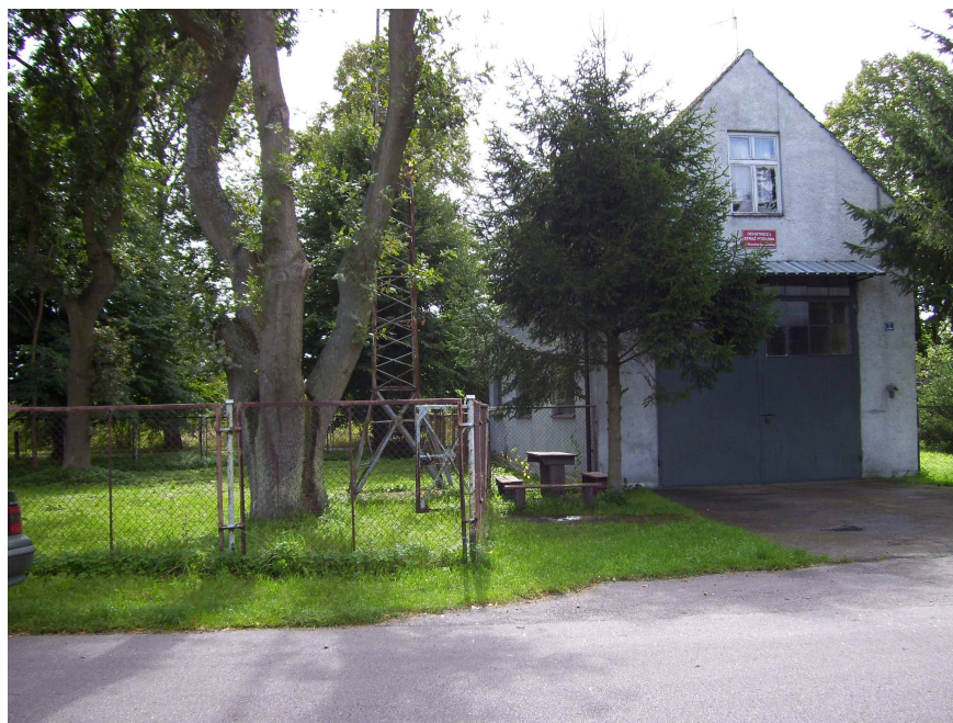
Budynek OSP w Wysokiej Kam. (stan przed planowanym remontem i rozbudową).
