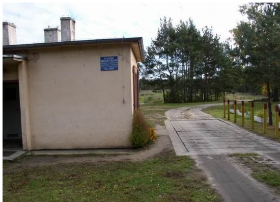
Zdjęcie 3 Infrastruktura składowiska w Słajsinie
