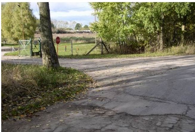
Zdjęcie 5 Droga dojazdowa do składowiska w Smolećcinie
