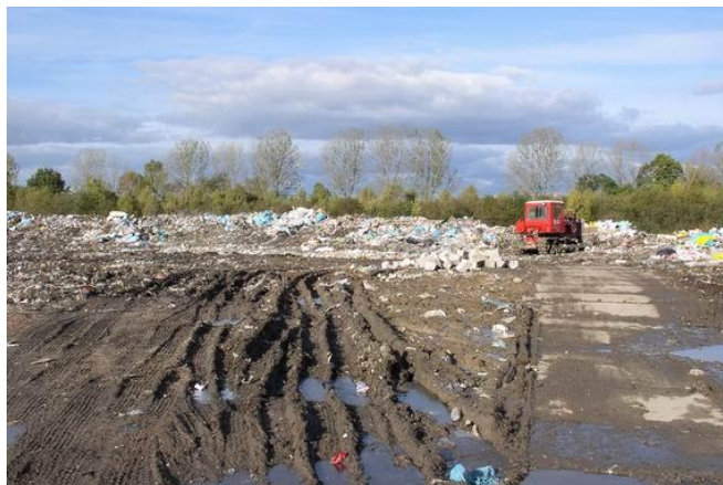
Zdjęcie 6 Składowisko w Smolęcinie
